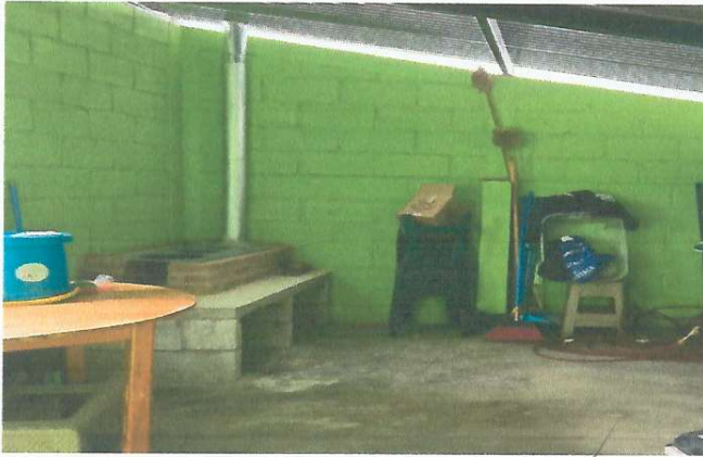
Foto1: mejoramiento de area de cocina
