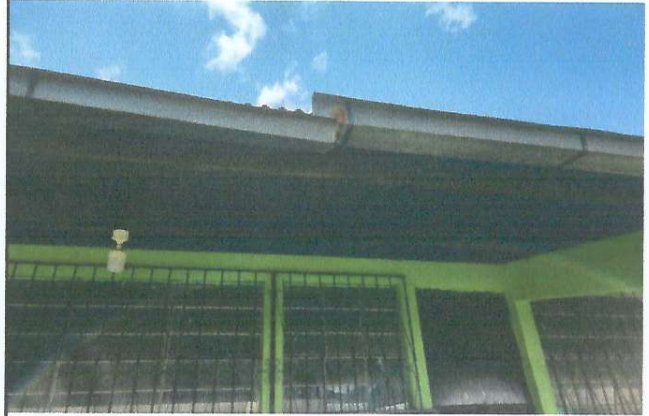
Foto 2: Mejoramiento de canales de agua pluvial
